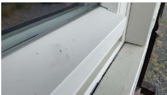
Anbefales vannbrettbeslag med fall utfra vindu
