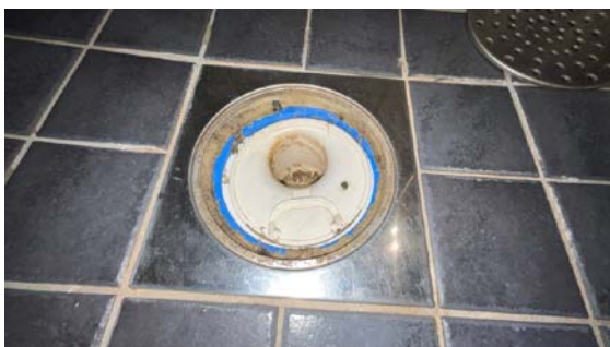
Kontroll av sluk.
