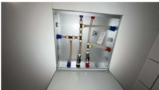
Besiktigelse av røropplegg.
