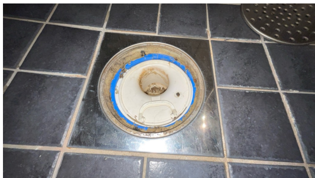
Kontroll av sluk.
