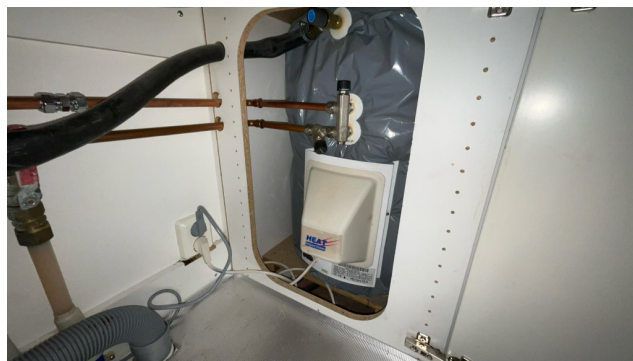
Besiktigelse av bereder.
