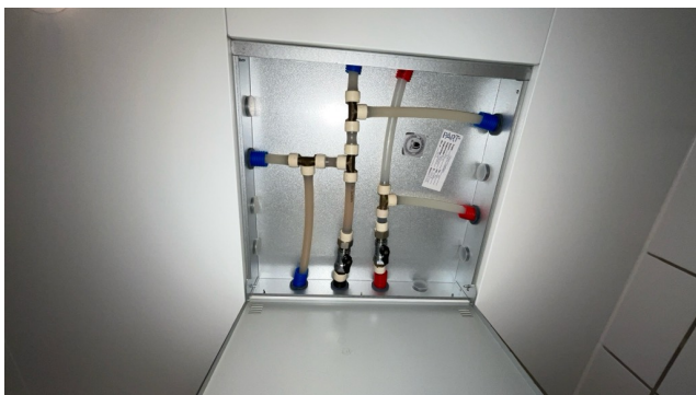
Besiktigelse av røropplegg.
