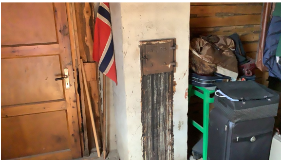
Rennemerker på pipe under feieluke
