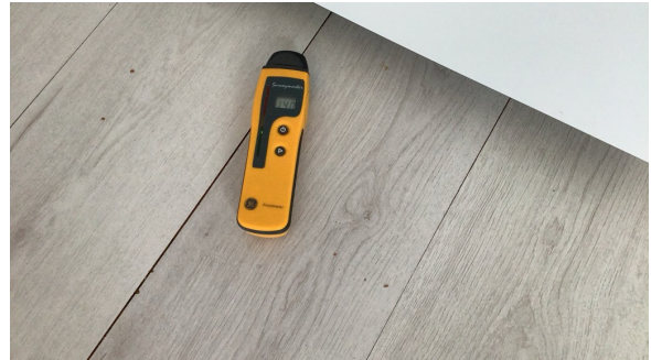
Skader i laminatgulv etter vann fra kjøleskap. Området var tørt på befaringen.
