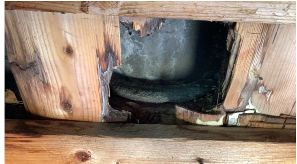
Åpning i undertaket etter tidligere lufting av avløp.
