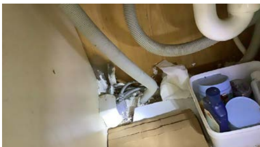
Netting og fugemasse i benk (vanligvis brukt for å tette mot mus)
