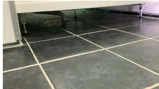
Slukområdet har noe lokalt fall mot sluk.
