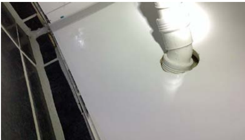
Utett gjennomføring i vegg.
