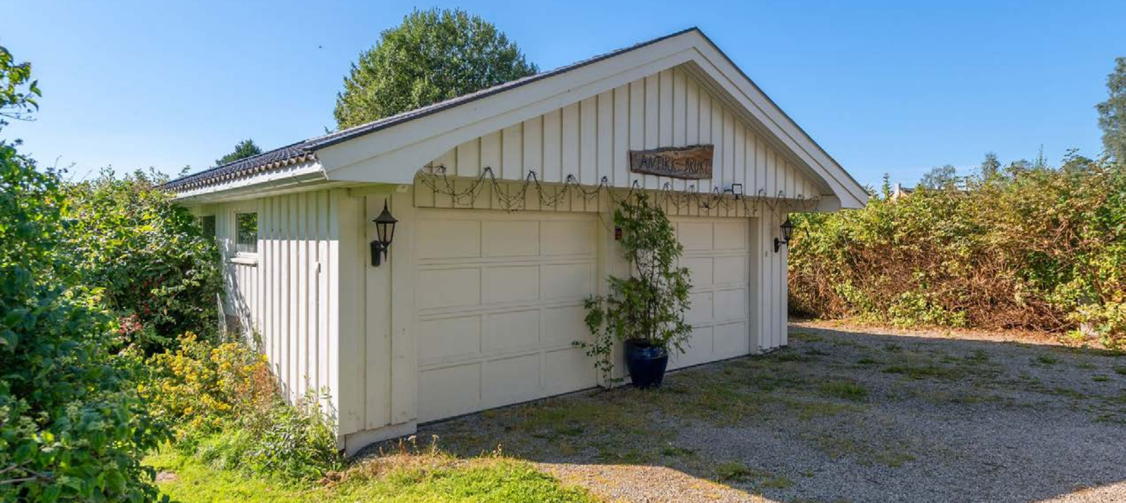
Isolert dobbelgarasje med bod på eiendommen.
