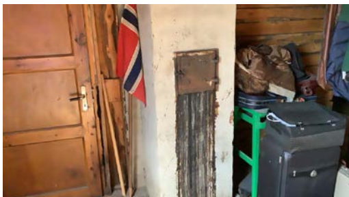
Rennemerke på pipe under feieluke
