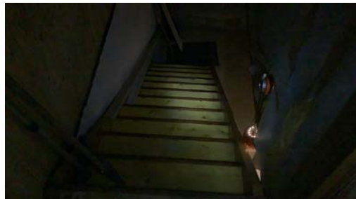
Trapp til kjeller mangler håndløper og rekkverk. Dette gir denne trappen tilstandsgrad 3.
