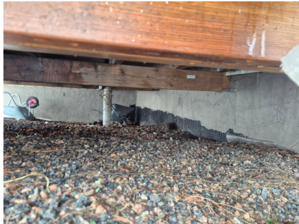
Synlig vorteplast mot grunnmur.
