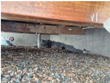
Synlig vorteplast mot grunnmur.
