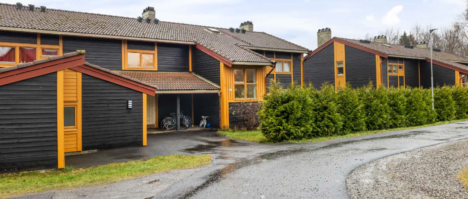
Asfaltert adkomst ved inngangspartiet til bygget, som ligger innerst i gaten til Grendelaget.
