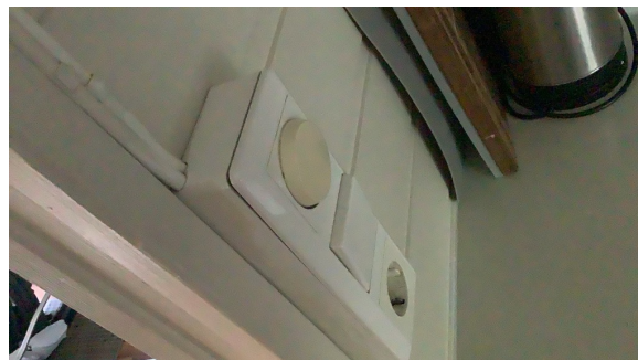
Det er løs dekkning rundt bryter.
