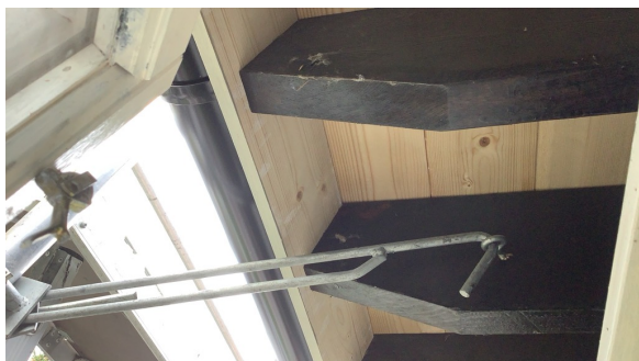
Deler av undertak er byttet ifbm ny taktekking.
