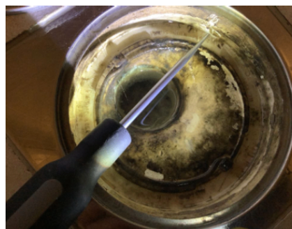
Ikke synlig klemring/ membran i sluk
