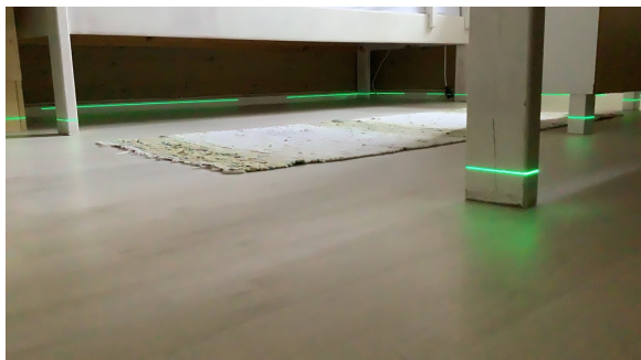
Måling av helningsavvik på etasjeskiller.
