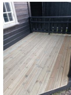
Bilde fra eier. Tilsendt etter befaringen.
