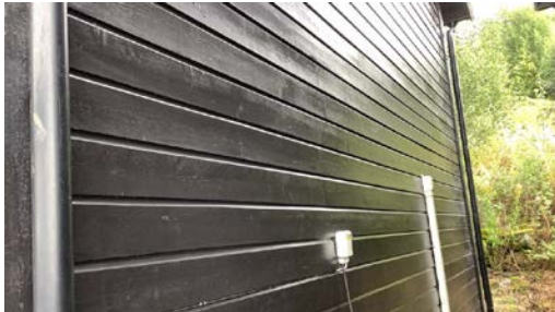
Kledningen er malt i år.
