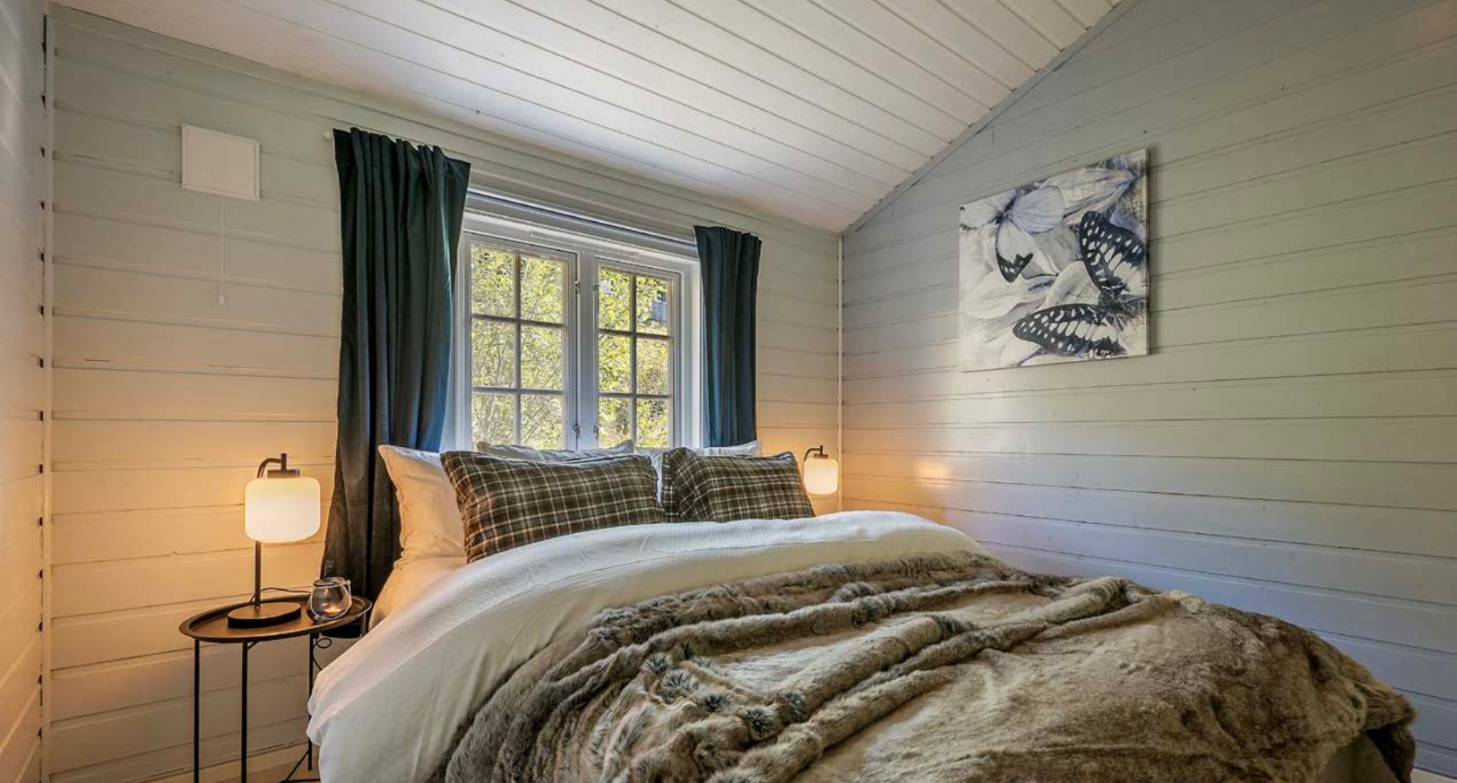
Soverom I. Ikke godkjent rømningsvindu.
