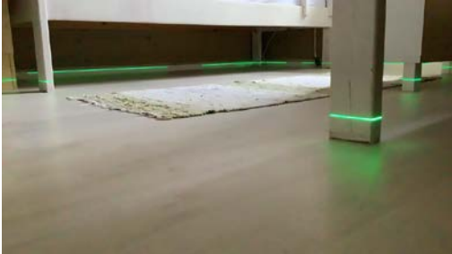
Måling av helningsavvik på etasjeskiller.
