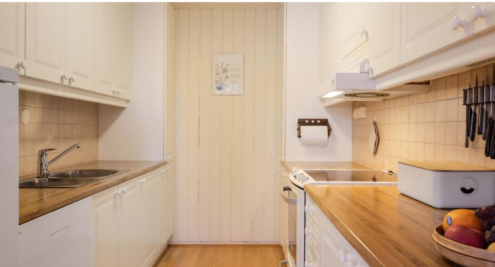
Innredningen går opp til himlingen, slik at støv ikke samler seg på toppen.
