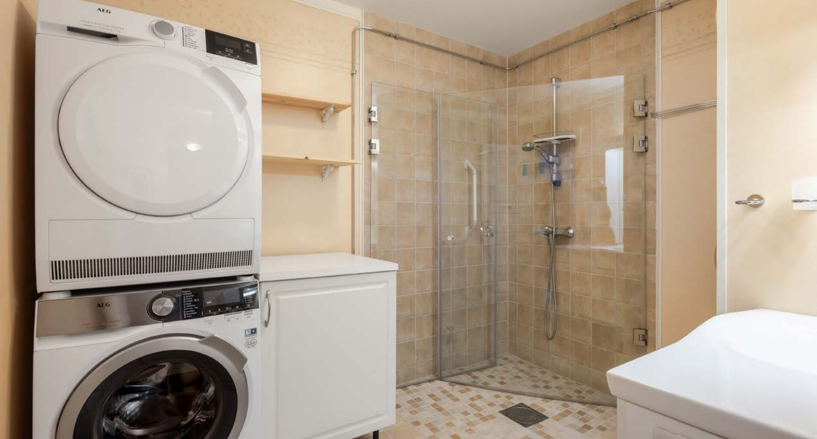
Badet er pusset opp i 2012 og har flislagt gulv med varmekabler. Veggene har en kombinasjon av fliser i dusjsone og vinylbelegg på øvrige vegger. Det er opplegg for vaskemaskin på badet.
