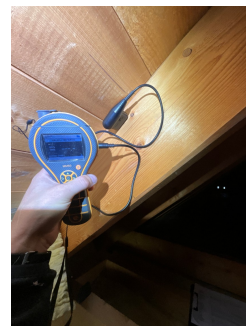
Ved stikkprøve kontroll med piggmåling ble det ikke påvist unormale forhold.
