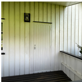
Balkongdør ut til luftbalkong. Harde tettepakninger
