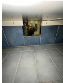
Utsparring i vegg for hovedstoppekrane
