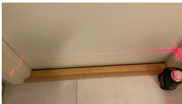
Tilluftspalte under dør
