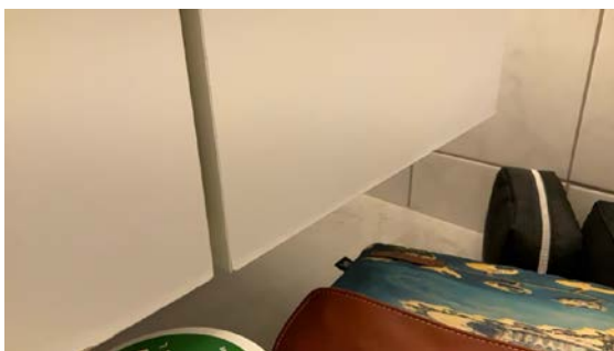
Utsvelt i nedkant av dør
