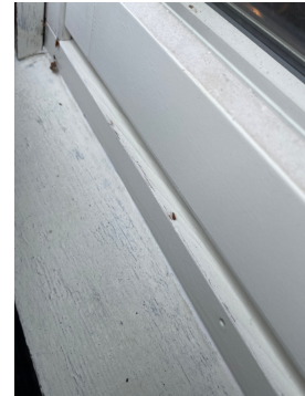
Værslitt/oppsprukket overflatebehandling.
