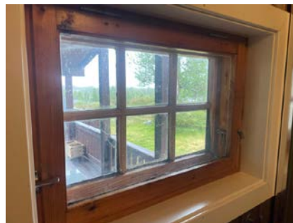
Tegn på kondensering i ytterdel.
