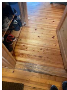
Stedvis sår/hakk utover normal slitasje.
