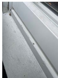
Værslitt/oppsprukket overflatebehandling.
