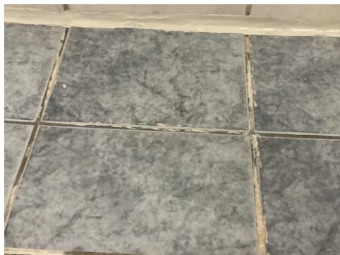
Noe kalk-utslag på fuger.
