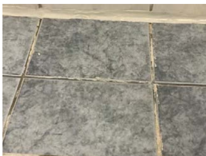
Noe kalk-utslag på fuger.
