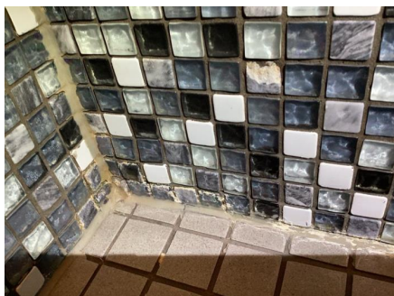
Liten knekt flis. Hullrom bak flis nederst i hjørnet.
