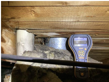
Ved enkel fuktmåling registrerte jeg tørre verdier.
