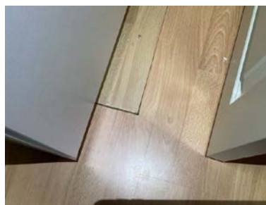
Ufagmessig utførelse på laminatgulv på et soverom.
