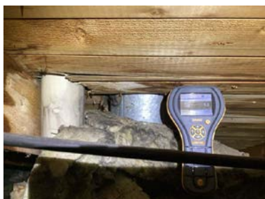
Ved enkel fuktmåling registrerte jeg tørre verdier.
