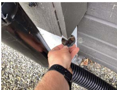
Det er observert åpninger i utvendig komplettering som øker risikoen for at mus kan komme inn.
