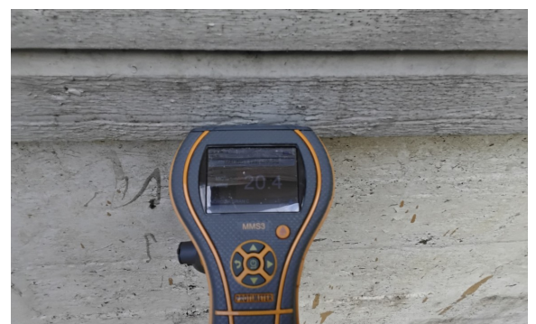
Fukt måling på utvendig kledning
