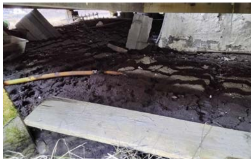
Søylepunktert på terrassen
