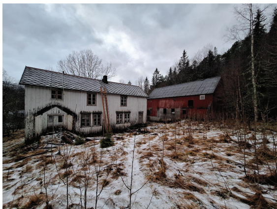
Bolig og driftsbygning med mye forfall
