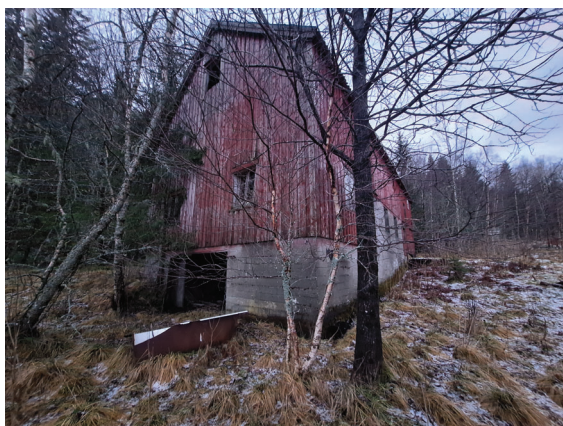
Driftsbygg fra sør side
