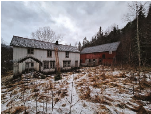
Bolig og driftsbygning med mye forfall
