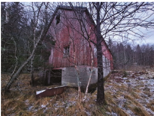
Driftsbygg fra sør side
