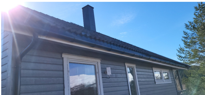
Takrenner mot nord av stål.
