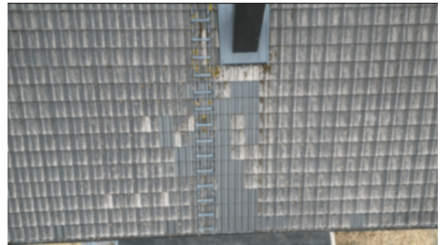
Enkelte steiner er byttet på taket.
