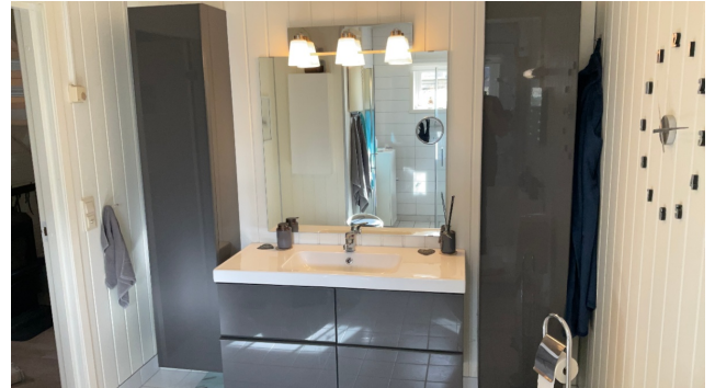
MDF- plater på vegg rundt servant.
