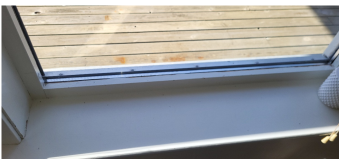
Vinduer fra byggeår.
