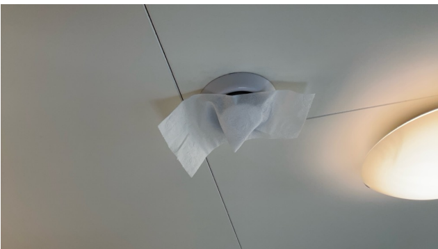
Test av avtrekk i himling.
