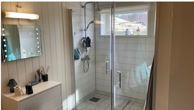
Dusjhjørne med våtromsplater.
