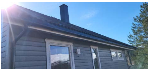
Takrenner mot nord av stål.
