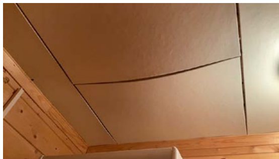
Himlingsplater er fuktskadet og utsvelt.
