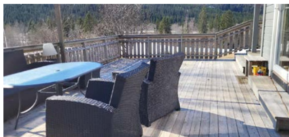
Terrasse over garasje.
