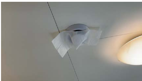
Test av avtrekk i himling.
