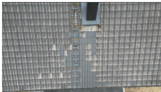
Enkelte steiner er byttet på taket.
