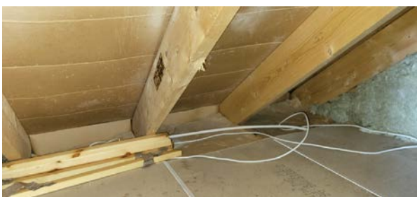
Ingen unormale forhold påvist bak knevegger på loft.
