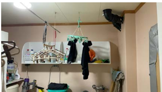
Vegger og tak på vaskerom.
