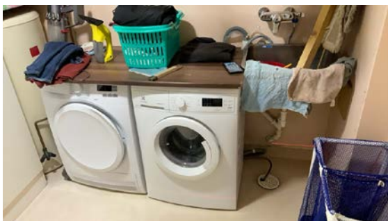
Vaskemaskin, tørketrommel og VVS- bereder.
