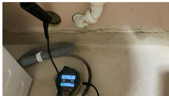
Ingen unormale forhold påvist ved hullboring i vegg på vaskerom.
