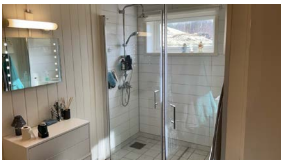
Dusjhjørne med våtromsplater.
