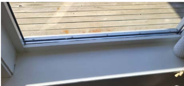
Vinduer fra byggeår.
