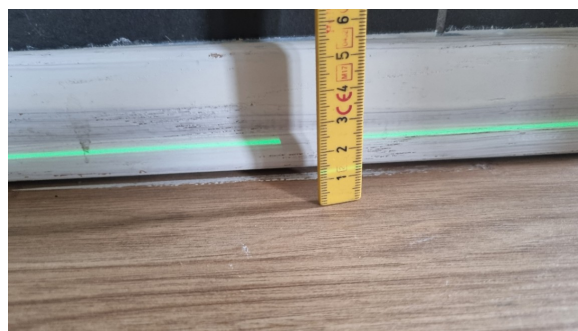
Kontroll av planavvik.
