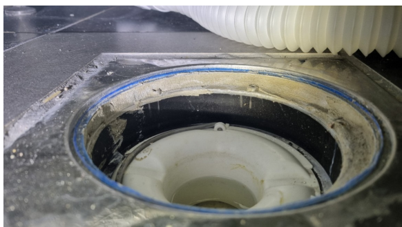
Kontroll av sluk.
