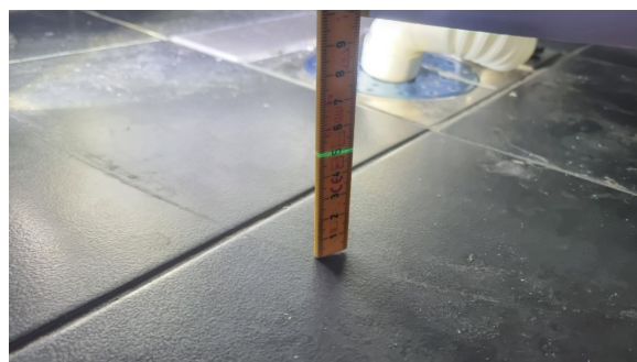
Gulvet har fall til sluk.
