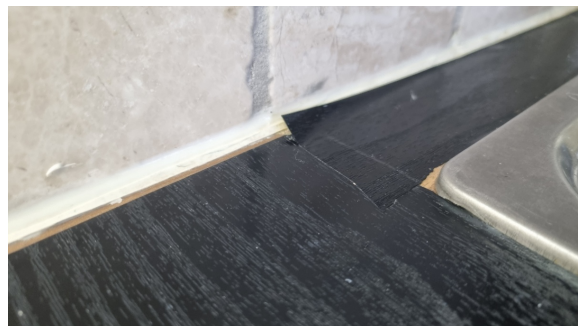
Ufagmessig utførelse av folie på benkeplate.
