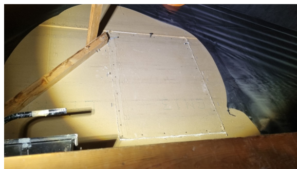
Adkomsten til kaldloftet var ved befaring igjenkledd.
