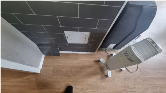
Ildfast plate mangler på gulvet under sotluke på pipe.
