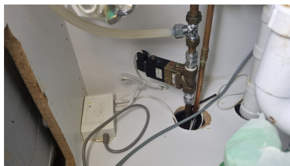
Det er montert waterguard.
