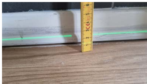
Kontroll av planavvik.
