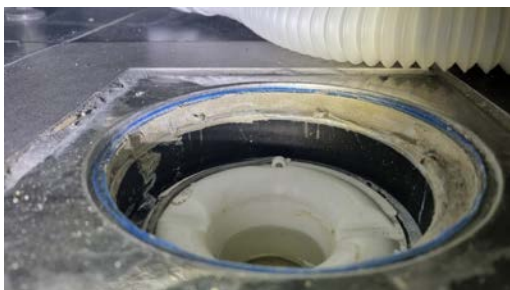
Kontroll av sluk.
