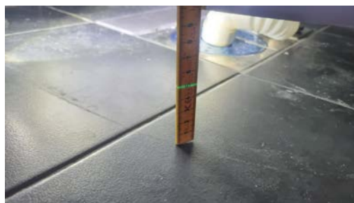
Gulvet har fall til sluk.
