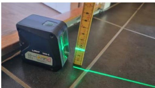
Kontroll av fall.
