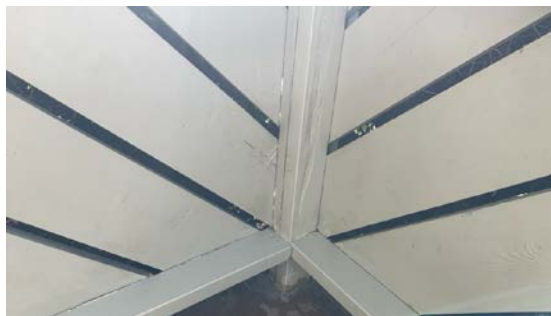
Råteskade i rekkverk.
