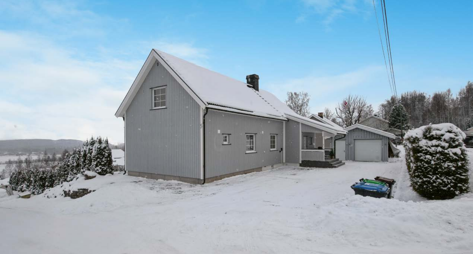
Eneboligen ble tilbygget en del i 2018/19.
