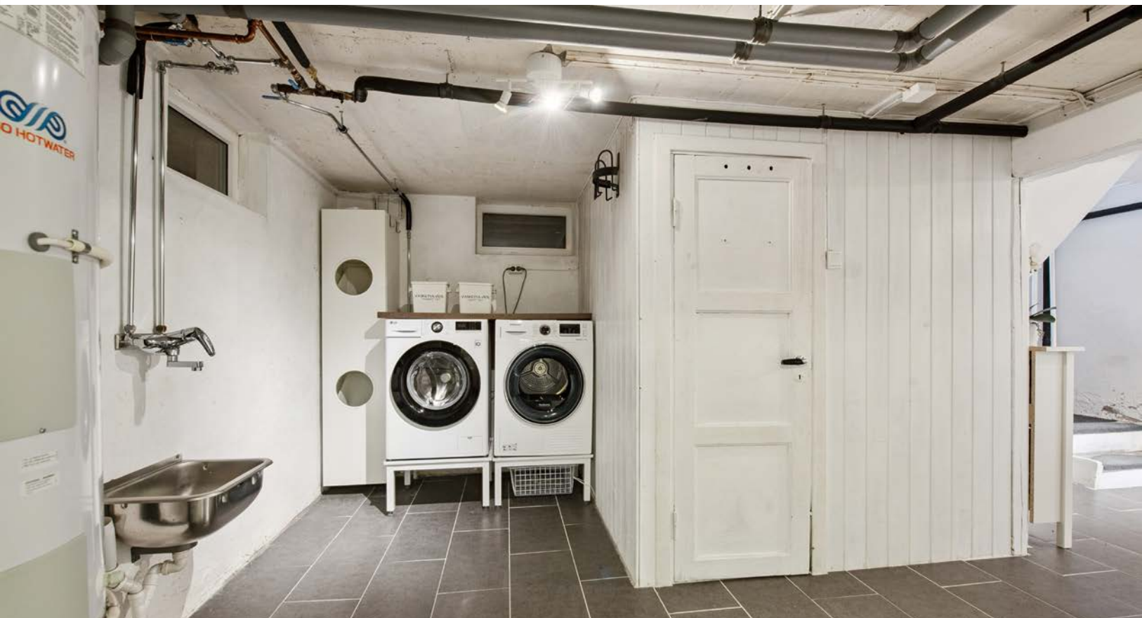
Vaskerom i kjeller ble oppgradert i 2014.
