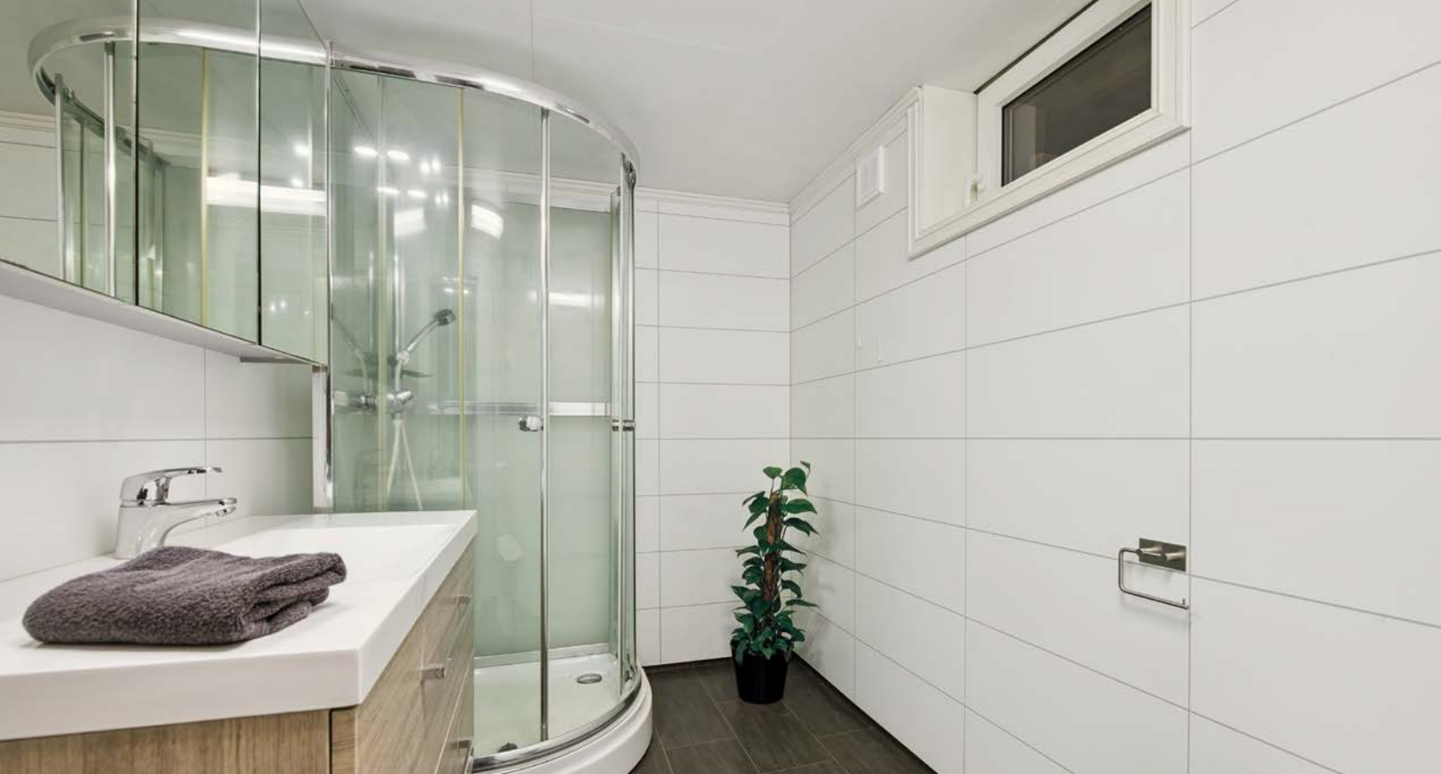
Flott bad i kjeller fra 2014, med vinylbelegg på gulv og våtromsplater på vegger.
