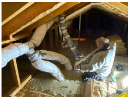
Deler av isolasjon er skiftet ut på loftet.
