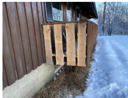
Det er montert nytt rekkverk mot vest
