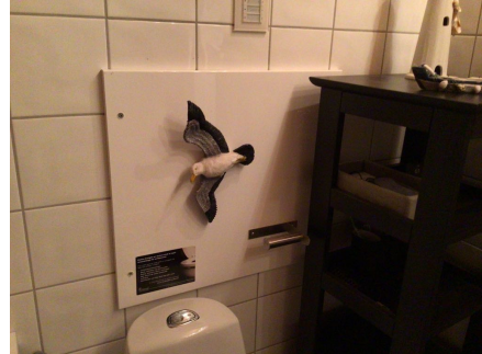
Skap til rør i rør system, her er også stoppekran til vann.
