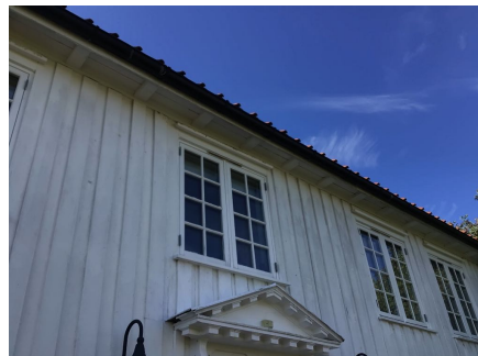
Eksempel på vindu i yttervegg.
