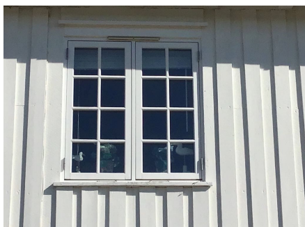
Eksempel på vindu i yttervegg.
