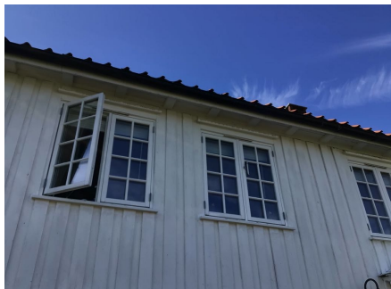
Eksempel på vindu i yttervegg.
