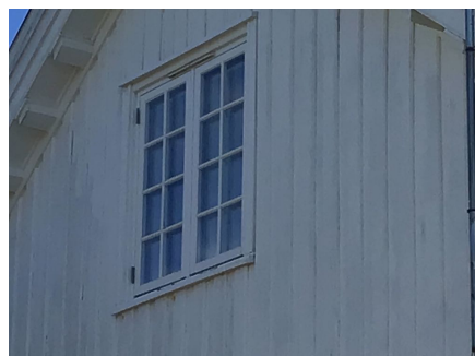
Eksempel på vindu i yttervegg.
