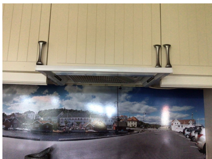
Montert avtrekk over komfyr.
