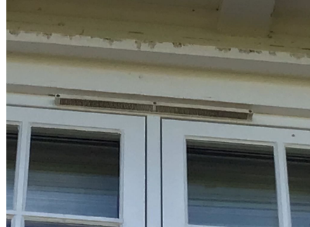
Eksempel på montert ventil i vindu.
