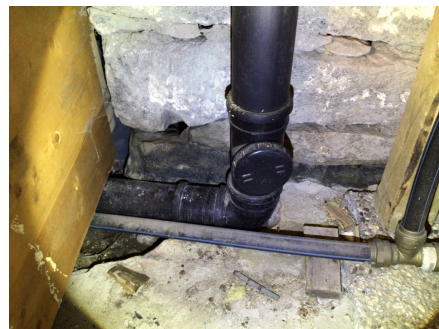
Del av rør til avløp. Stakeluke i kjeller.
