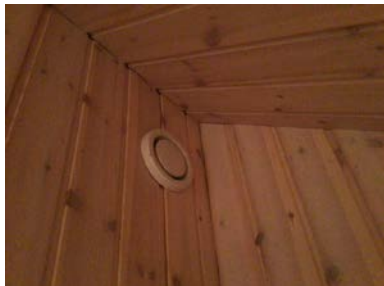
Eksempel på montert ventil i vegg.
