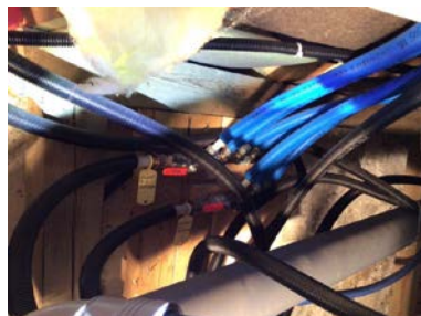
Del av rør til vann.
