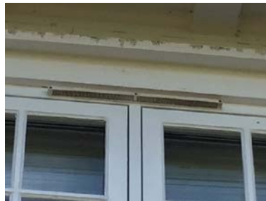
Eksempel på montert ventil i vindu.
