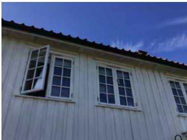
Eksempel på vindu i yttervegg.
