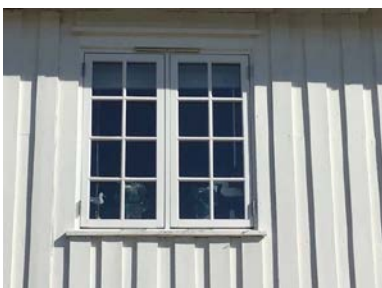
Eksempel på vindu i yttervegg.
