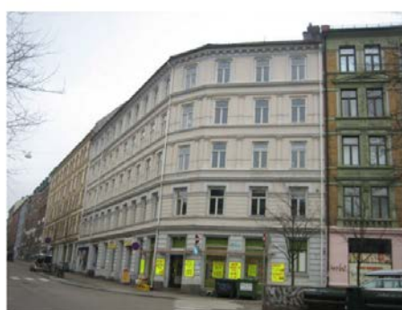
Fasade mot gate
