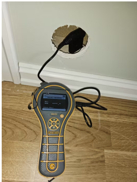
Bilde viser fuktmåling.
