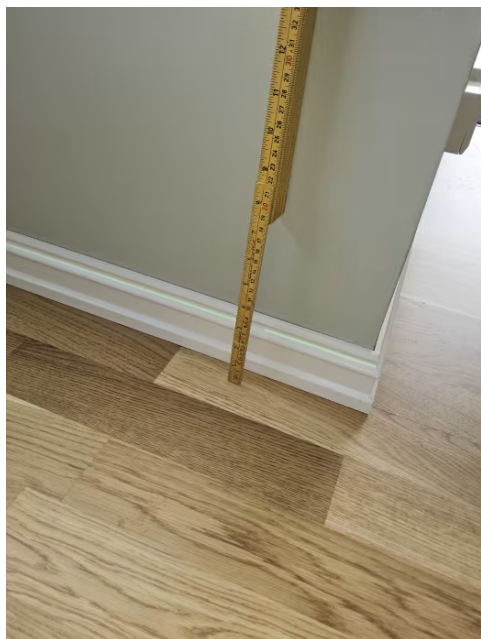
Bilde viser måling av etasjeskiller.
