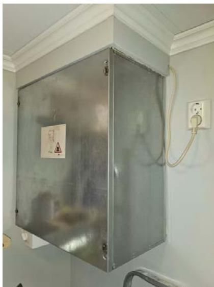
Bilde viser ventilasjonsaggregat.
