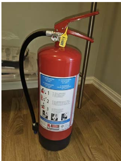
Bilde viser brannslukningsapparat.
