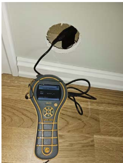
Bilde viser fuktmåling.
