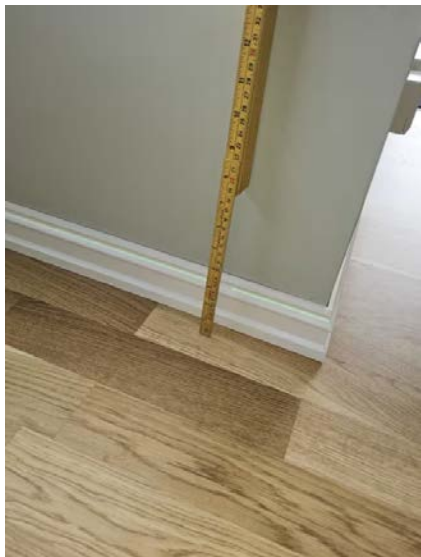
Bilde viser måling av etasjeskiller.
