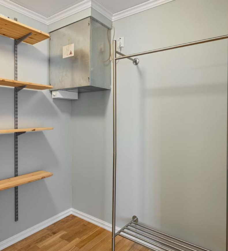
Bod/teknisk rom i tilknytning til entréen.
