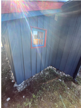
Terrenget faller inn mot byggets grunnmur
