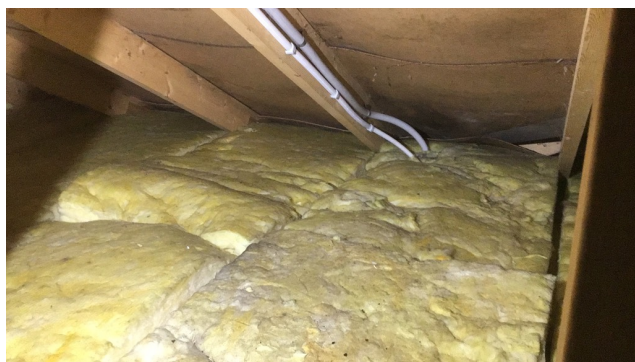
Isolasjonen går mot undertaket
