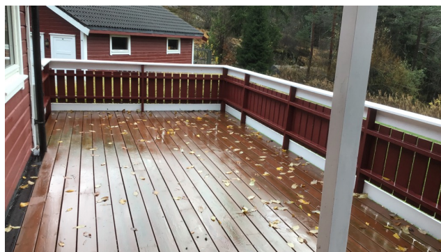
Terrase ved inngang
