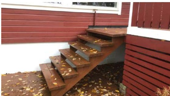
Mangler rekkverk
