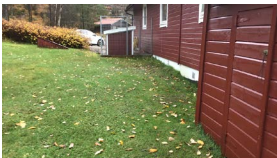
Terreng har fall inn mot grunnmur
