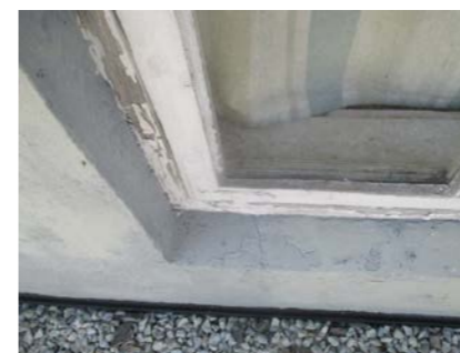
Eldre opprinnelige kjellervinduer.
