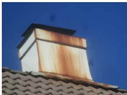
Noe slitt pipehatt.
