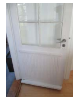
Eldre dør til vindfang. (tidligere ytterdør)
