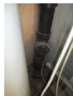
Avløpsrør av plast med stakeluke.
