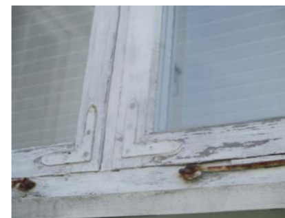
Eldre slitt vindu på kjøkken.
