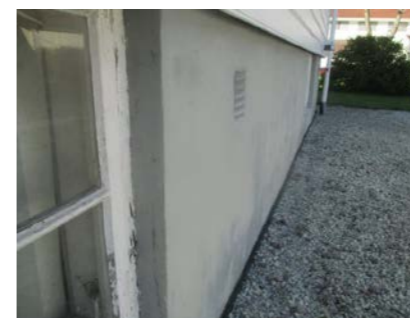
Deler av grunnmur.
