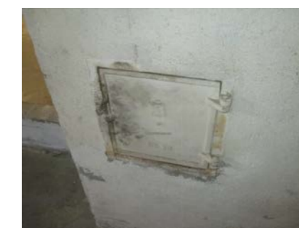
Sotluke i grovkjeller.
