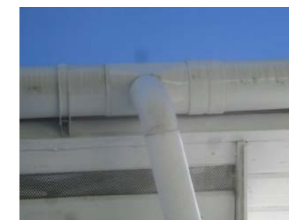
Takrenner og nedløp av plast.
