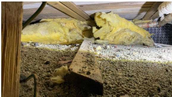
Bilde fra krypkjeller.
