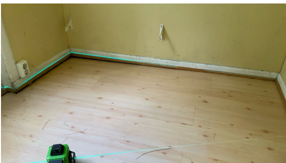
Høydeforskjell er målt med laser.
