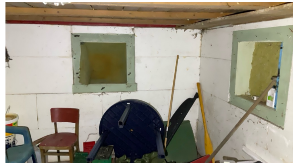
Grunnmur kledd innvendig med isopor.
