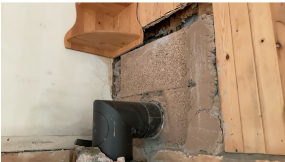
Treverk for nærmere røykrør i stuen
