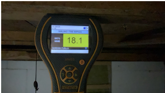
Fuktmåling i bjelker.
