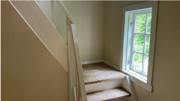
Vindu i gangretning i trappen
