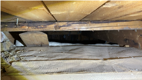
Delvis lufting av undertak.
