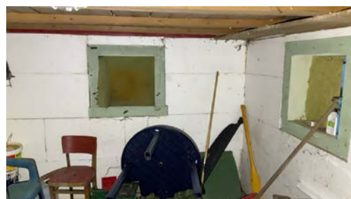
Grunnmur kledd innvendig med isopor.
