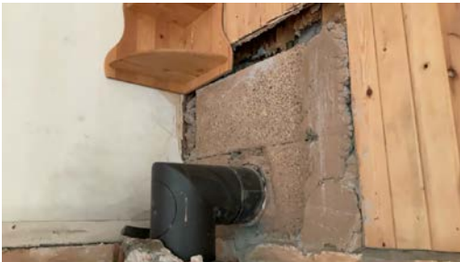
Treverk for nærmere røykrør i stuen
