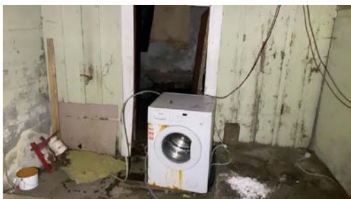
Enkelt vaskerom i kjelleren
