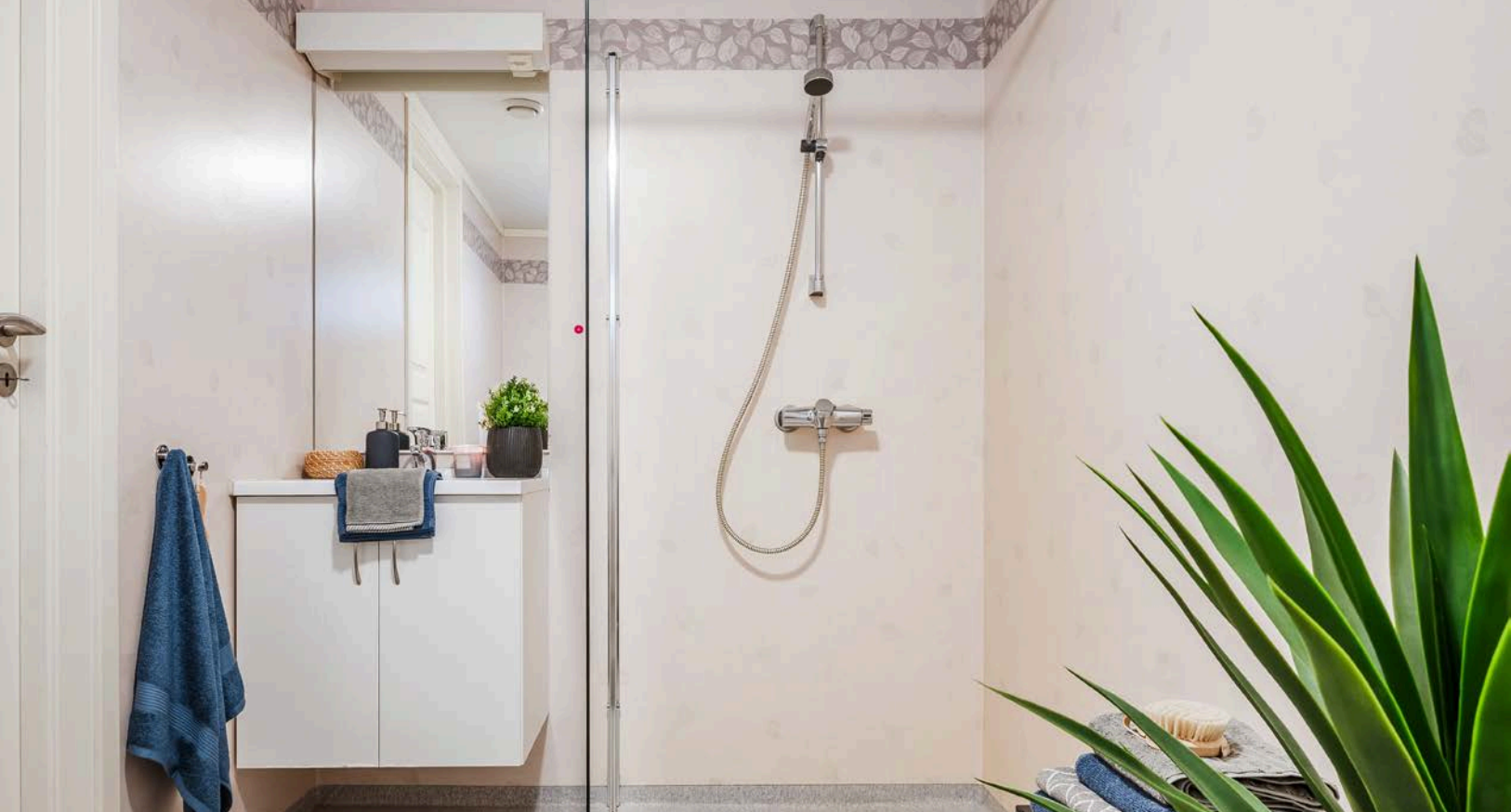
Baderom fra 2013 med belegg på gulv, elektrisk gulvvarme, overflater med våtromsbelegg og balansert ventilasjon
