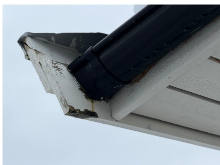
Værslett overflatebehandling på vindskibord.
