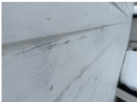
Eksempel på tynnslett overflatebehandling.
