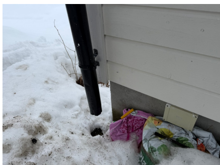
Takrennenedløp ved grunnmur.
