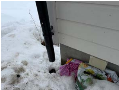
Takrennenedløp ved grunnmur.
