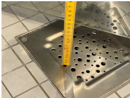
Fallforhold ca. 135 mm topp slukrist i dusjsone
