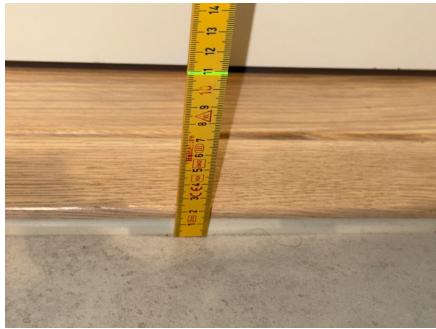
Fallforhold ca. 109 mm overkant gulv ved terskel
