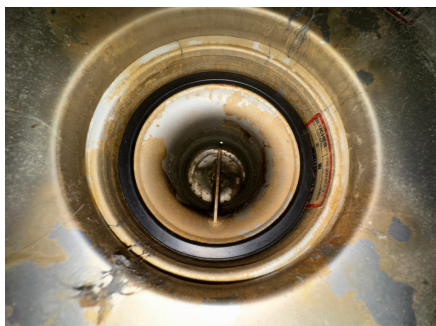
Stålsluk med vannlås i dusjsone
