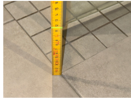
Fallforhold ca. 116 mm overkant gulv ved dusjsone
