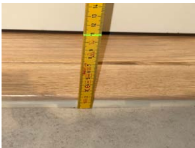
Fallforhold ca. 109 mm overkant gulv ved terskel
