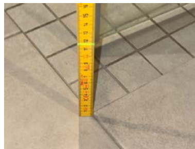
Fallforhold ca. 116 mm overkant gulv ved dusjsone
