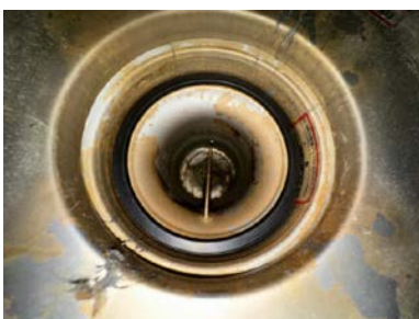
Stålsluk med vannlås i dusjsone
